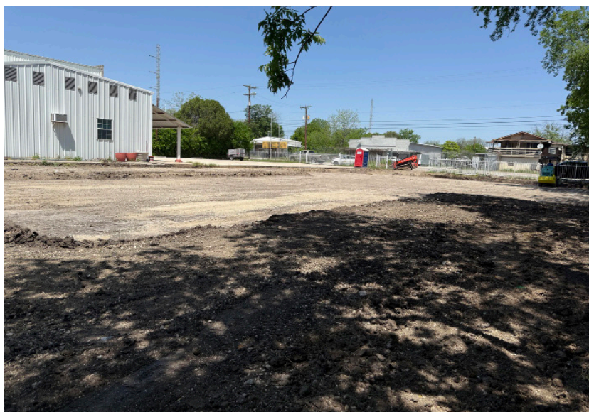
Công Trình Xây Dựng Thánh Thất
